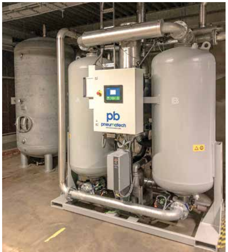
De adsorptiedroger in Schoonrewoerd, voor perslucht van hoge kwaliteit <
