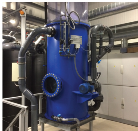
De eiwitafschiemer verwijdert de eiwitten uit het zoetwaterbassin.
