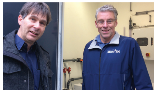
Johan Blanckaert, sales engineer bij ALUP GrassAir, en Frank Simon, manager techniek bij Burgers' Zoo in de compressorruimte
