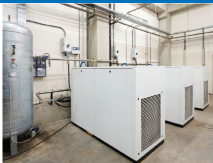
De drie olievrije frequentiereguleerde watergekoelde schroefcompressoren met ingebouwde koeldroger, type WisAIR 40VTW. Daarvoor staat de 1000 liter persluchtkeutel.
