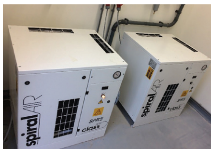
De twee olievrije SpiralAir 5 compressoren, die om de beurt draaien.
