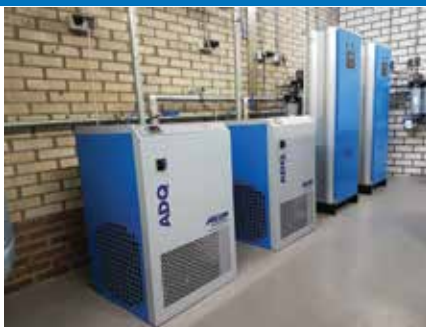
De persluchtconditionering bestaat uit twee ADQ koeldrogers, twee AD adsorptiedrogers en een uitgebreide filterstraat.
