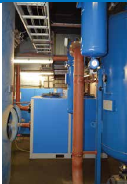
Rechts op de voorgrond de adsorptie unit die alleen in de wintermaanden wordt gebruikt. Op de achtergrond de koeldroger en links de grote buffertank.
