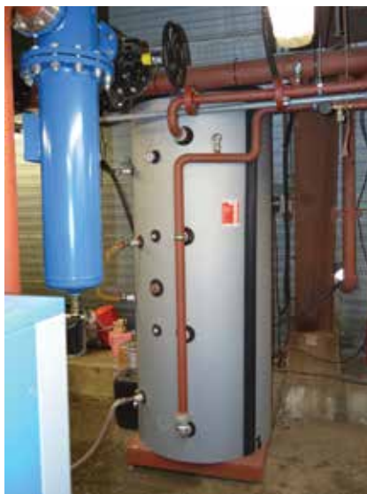
Testopstelling met de boiler die dient als opslag voor de warmte uit de compressoren. Via leidingen met glycol wordt deze warmte naar luchtheaters in de hallen gepompt, waardoor wordt bespaard op aardgas.
